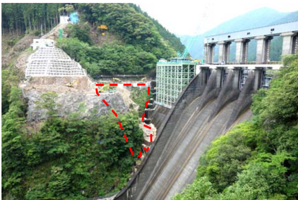
写真-1 ダム右岸掘削箇所とダム堤体
