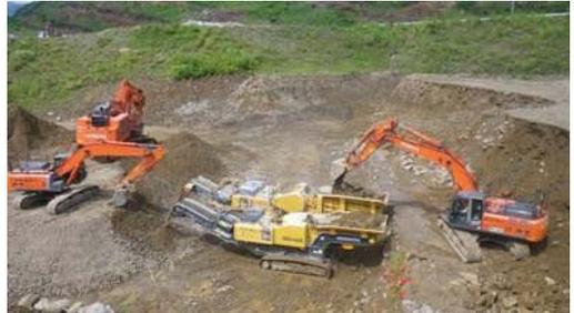
写真 1 CSG 材製造状況
