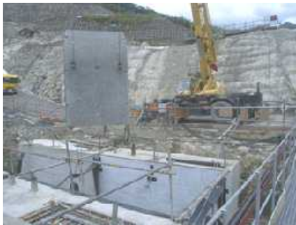
写真-1 PCa 型枠の吊り込み状況
