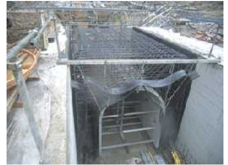
写真-3 周囲の配筋が完了した状況
