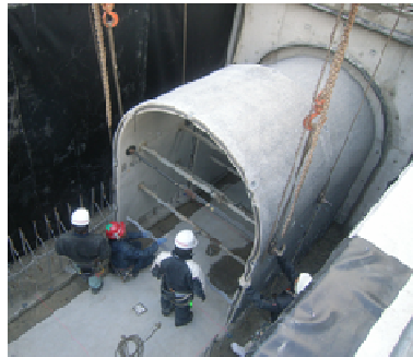
写真-2 PCa 型枠の設置状況
