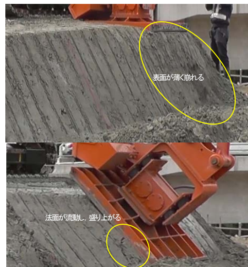
写真-3 端部締固め時の状況（VC 値 10 秒，法面勾配 1 : 0.8，締固め 15 秒）
