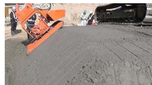
写真-4 端部締固め時の状況（VC 値 10 秒，法面勾配 1 : 1.0，締固め 15 秒）
