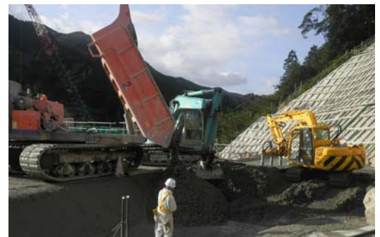
写真-1 巡航 RCD 工法における有スランプ岩着コンクリートの施工状況
