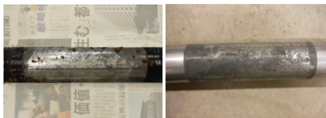
図-3 室内試験後の土壌付着状況(左)と変色状況(右)
