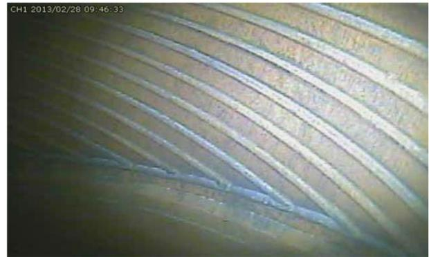
写真-2 水中カメラによる鋼管内清掃完了状況
