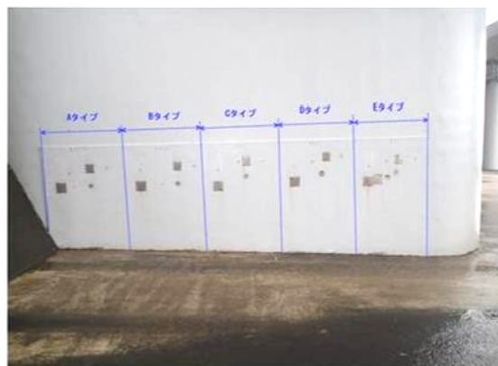
写真 2.1 試験施工箇所
