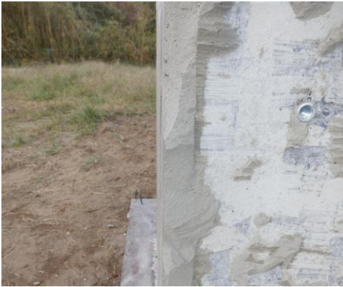
写真－1 はつり後のグラウトの充填状態
