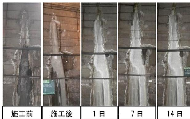
図-3 施工結果(止水工②)
