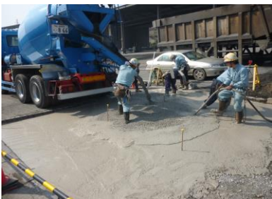
写真-2 施工状況
