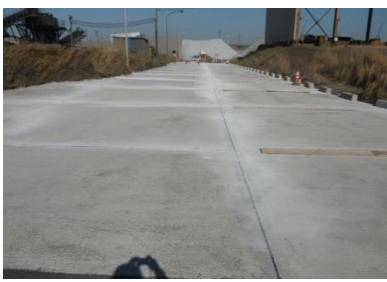
写真-3 施工後の状況
