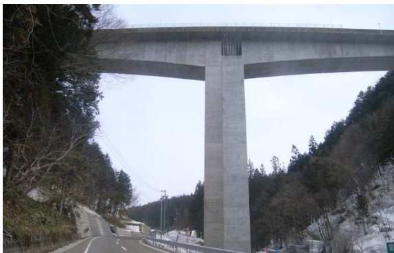
橋りょう下部工全景
