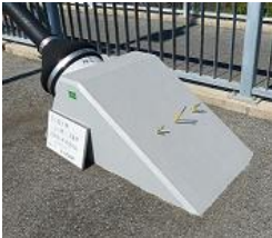
写真-2 保護コンクリート
