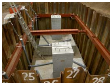
写真-1 供試体設置状況
