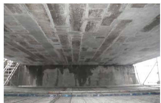
写真-4 B 橋の補修完了後状況
