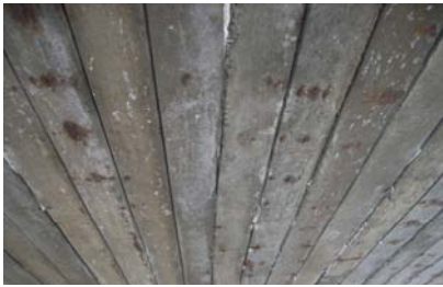
写真-2 B橋の外観状況
