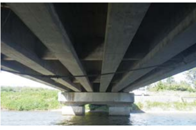
写真-1 A橋の外観状況
