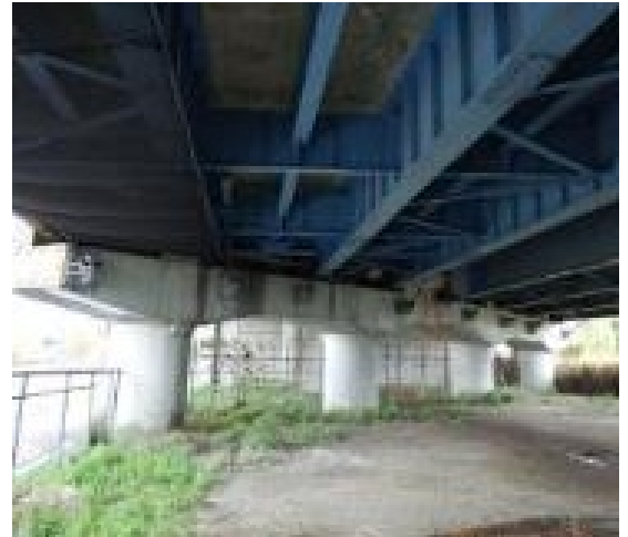
図 1 計測対象橋梁
