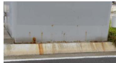
図-1 鋼板巻立て補強された橋脚に生じた変状の例
