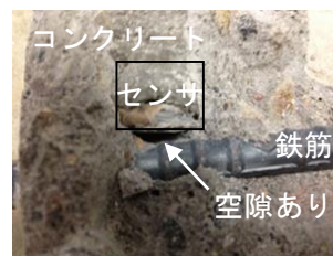
図3 先端フラット形状の埋設状況
