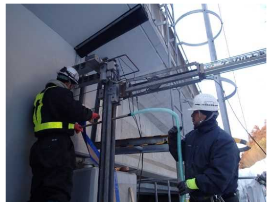
写真-1 ワイヤー装置全景
