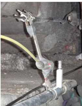
写真-3 ワイヤーと削孔ビット
