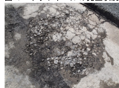
図-2 コンクリート床版の砂利化
