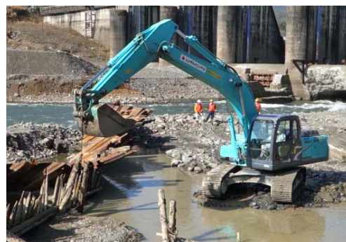
写真-1 牛杵の引抜き状況
