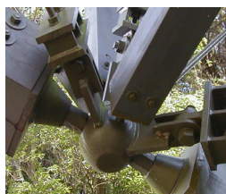
写真-2 鋼製ボールジョイント部
