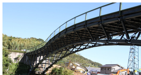
写真-1 対象橋梁
