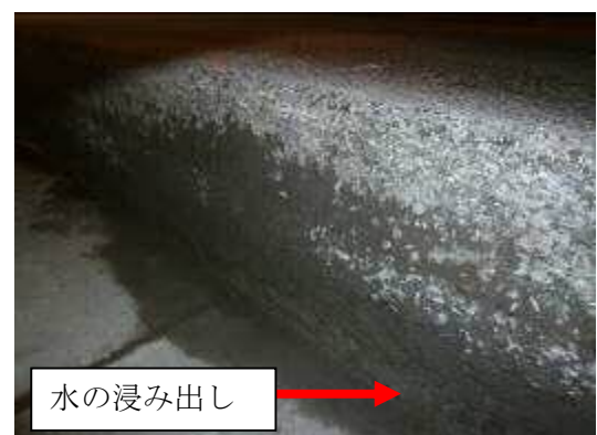
写真3 施工時の状況
