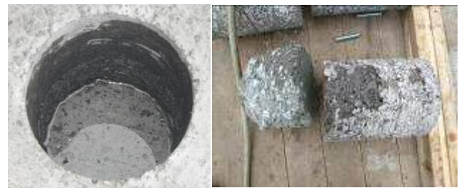
写真1 舗装のコア抜きの様子
