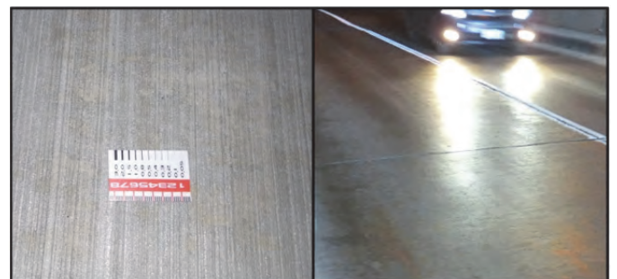
写真-1 左：施工直後の Co 舗装のほうき目仕上げ 右：供用に伴い光沢を帯びた Co 舗装路面
