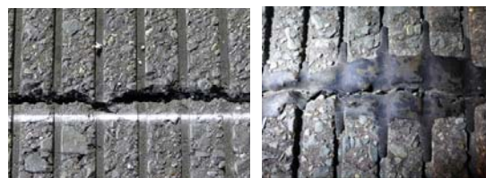
写真-1 施工継ぎ目の状況
