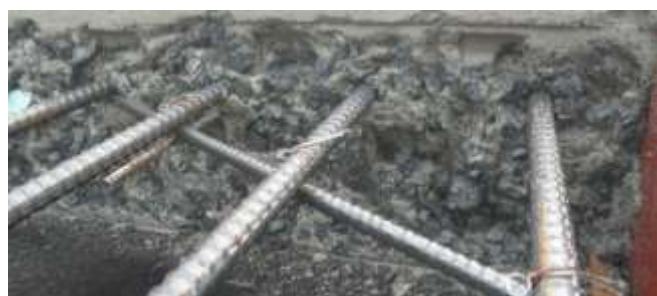
写真2：洗い出し後の施工継ぎ目状況
