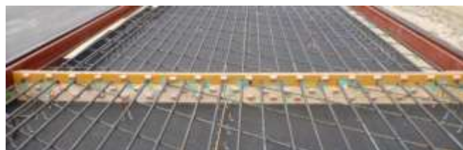
写真1：施工継ぎ目の型枠
