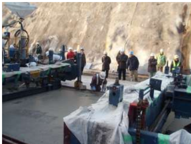
写真4：セットフォームによる施工の様子
