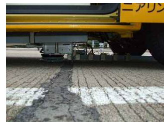
写真-3 FWD 目地測定状況
