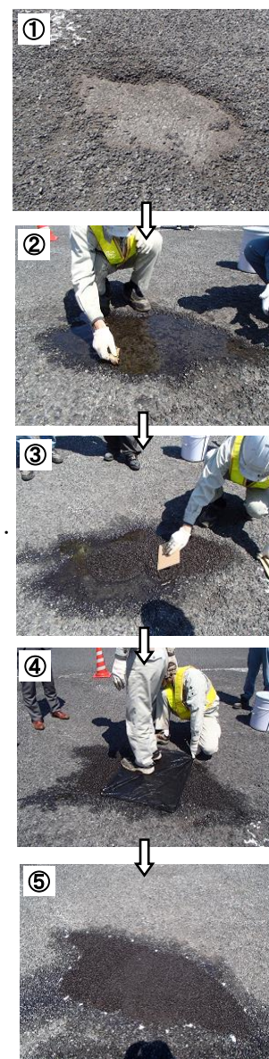
写真-2 補修作業状況
