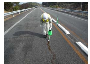
写真-2 施工状況
