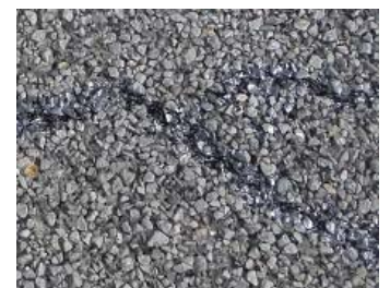
写真-3 施工表面
