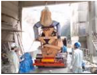
写真-5 設置型クレーン投入
