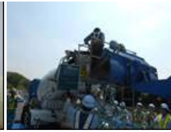
写真-7 移動足場投入
