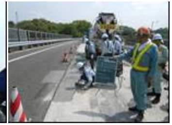
写真-8 打設状況
