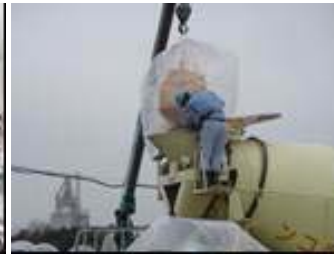
写真-6 トラッククレーン投入
