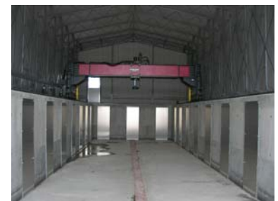
写真-1 繰返し載荷試験施設
