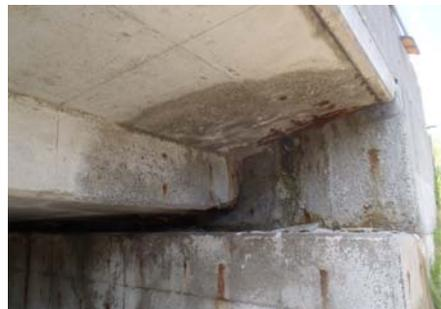
写真-1 橋梁桁端部劣化状況
