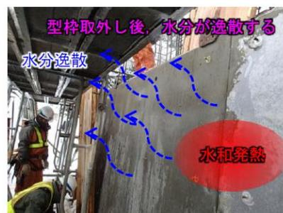
写真-1 型枠取外し直後のコンクリート状況
