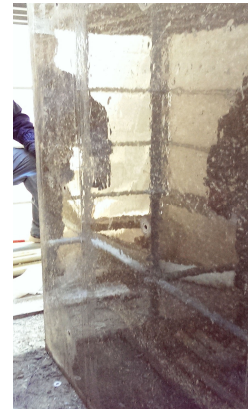
写真-2 シート取外し後のコンクリート表面
