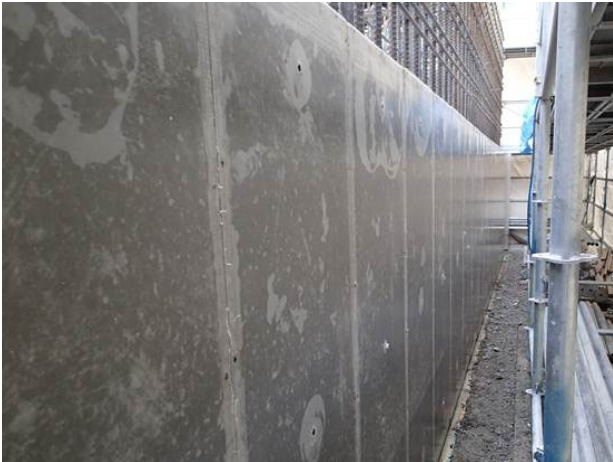
写真-1 型枠取外し後のシート養生状況（シート残置状況）
