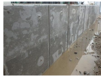
写真-1 シート残置による養生状況
