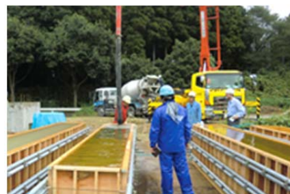
写真1 型枠および打ち込み状況
