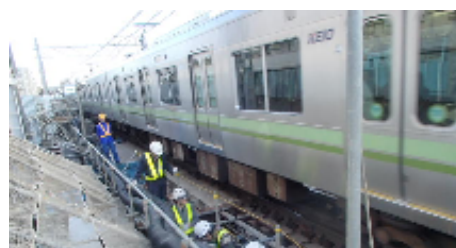
写真-2 打込み時の状況
