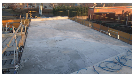
写真-2 打設後の状況 (上面)
