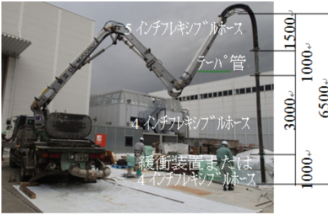
単位：mm 図－3 打込み方法 単位：mm 図－2 試験装置
