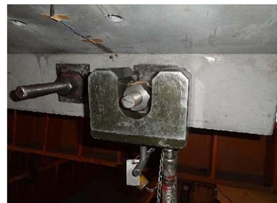
写真－2 ねじ棒圧着方式緊張状況
