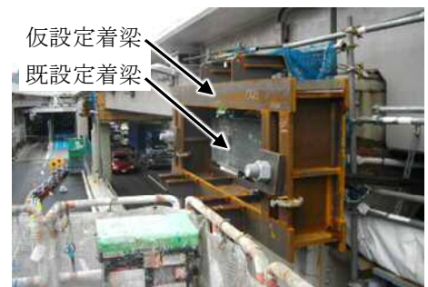
写真-5 既設・仮設定着梁
