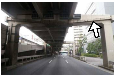
写真-1 再補強前の P C 外ケーブル
