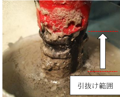
写真 4 引抜け破壊(S2)
