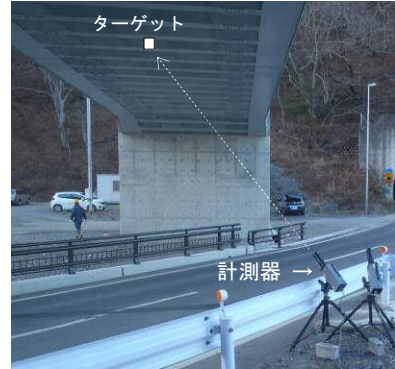
写真-1 Uドップラー計測状況
