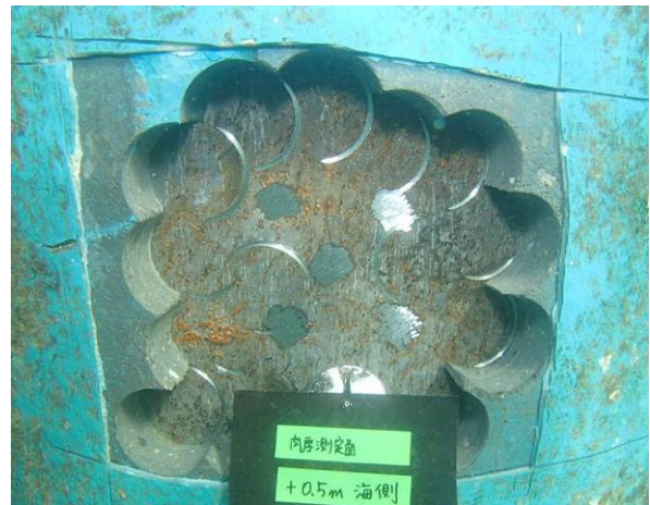
写真-2 鋼管杭表面確認状況(+0.5m 海側)
