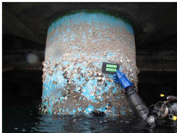
写真-1 外観目視調査状況
