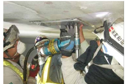
写真-1 犠牲陽極材の設置状況
