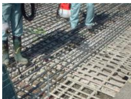
図-1 遮蔽型マクロセル対策工法
