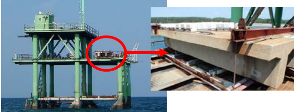
写真-1 海洋技術総合研究施設
