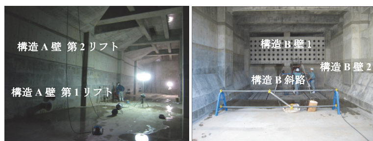
図-1 調査対象部材状況
