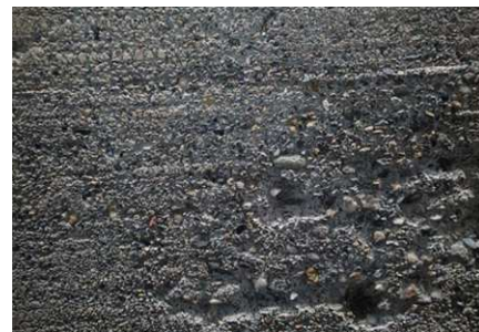
写真-6 表面処理施工後
