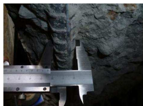
写真-4 鉄筋の腐食度調査
