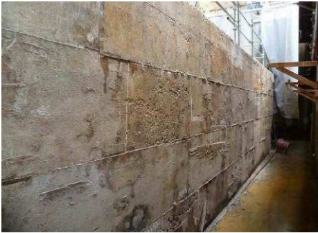
写真-1 既設フーチング外観
