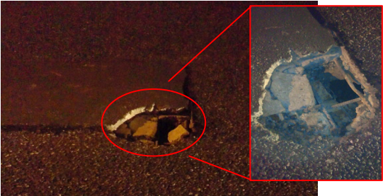
写真-1 抜け落ち事例
